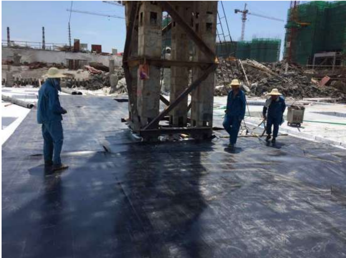
图 2.7 原位阻隔施工
