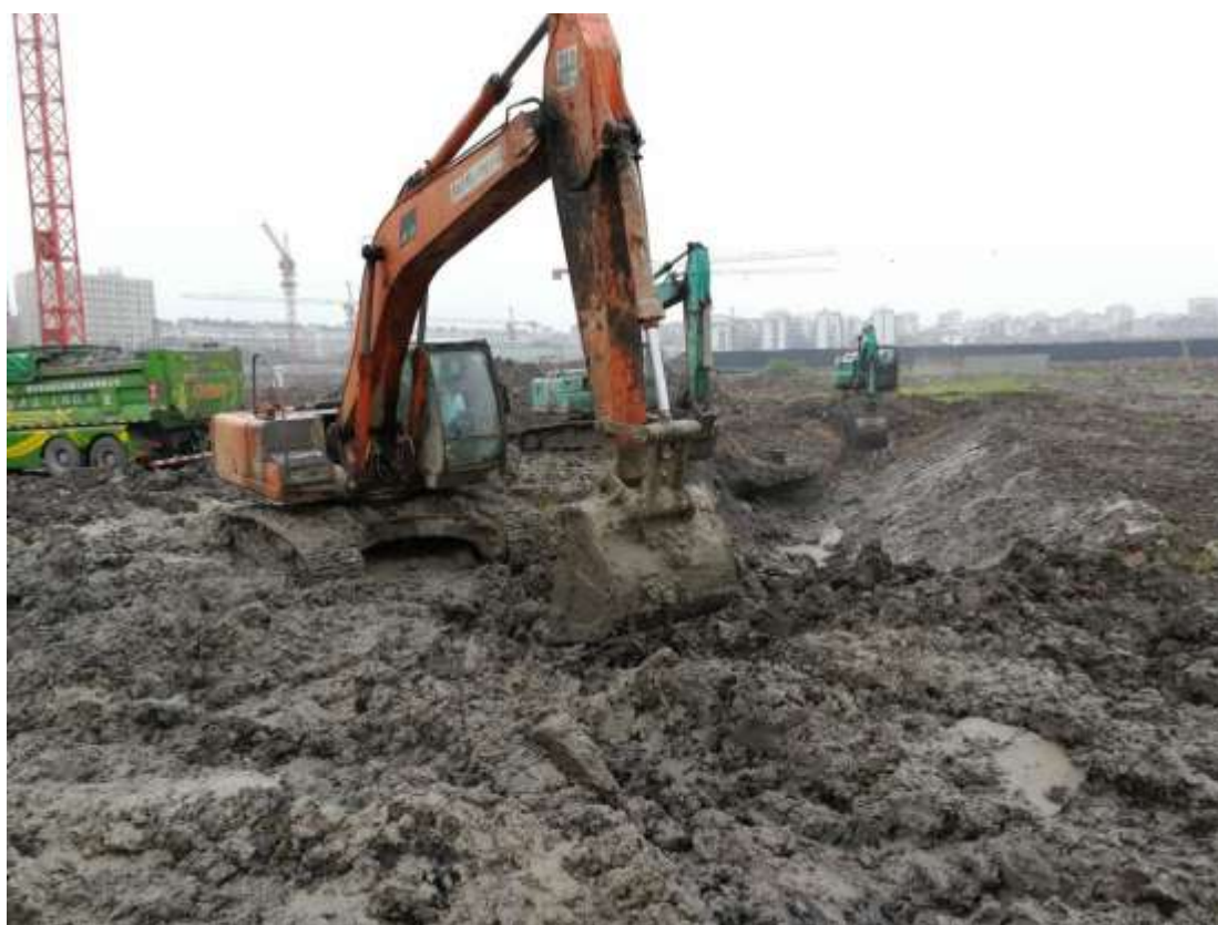
图 2.3 分层放坡开挖污染土
