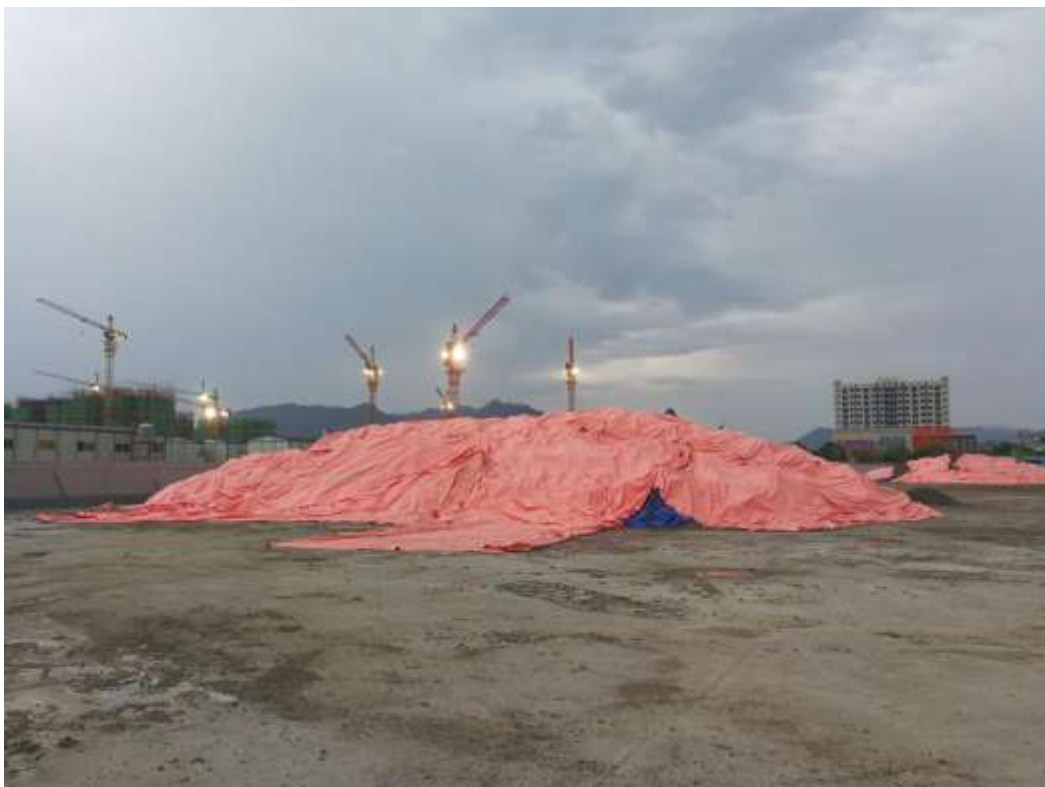
图 2.6 处置场污染土壤覆盖
