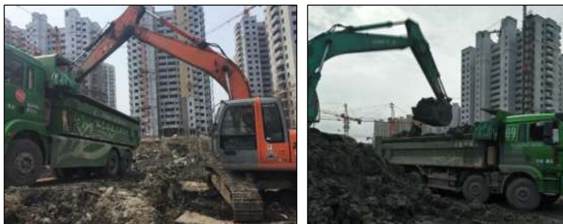
图 4-3 污染土壤开挖
