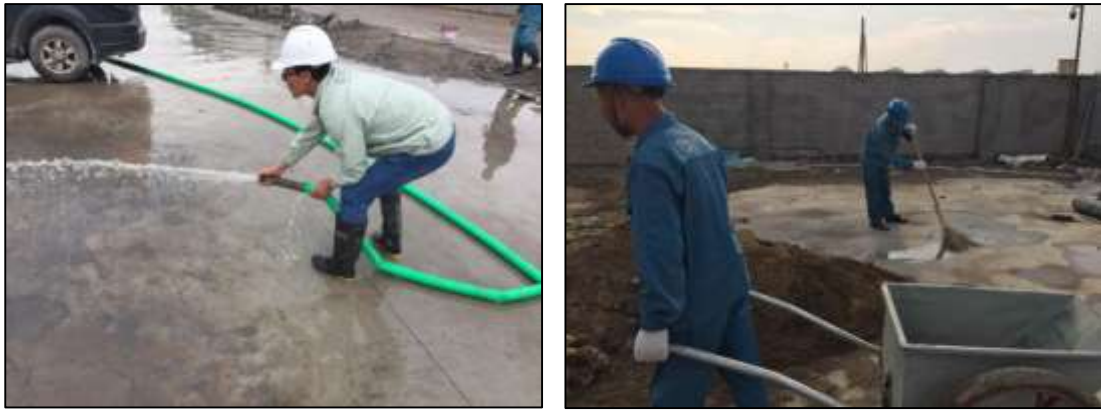
图 6-1 地面冲洗及洒落土壤清理
