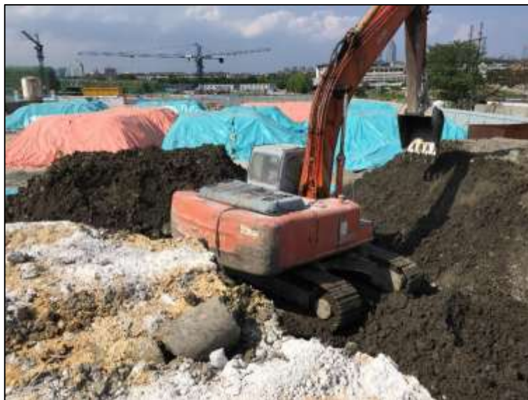
图 4-7 多环芳烃污染土壤化学氧化处理
