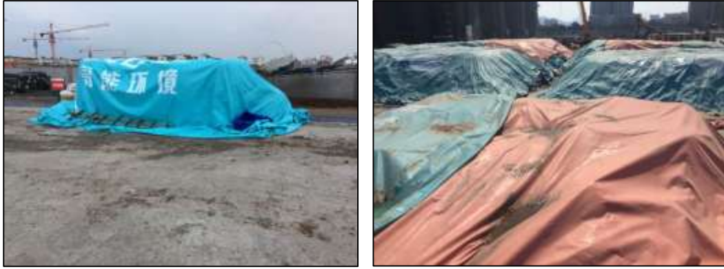
图 6-2 现场药剂存放（左）与土壤覆盖（右）
